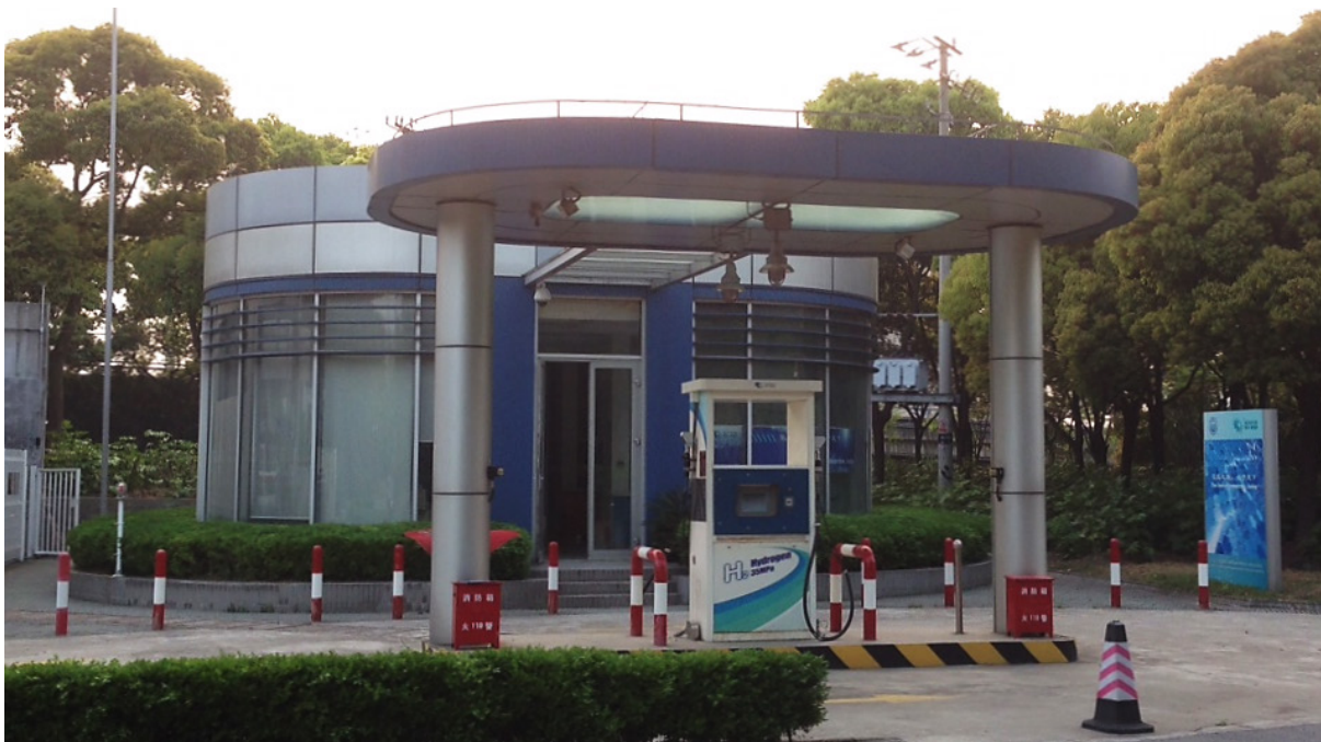
Abbildung 4: Wasserstofftankstelle in Shanghai
