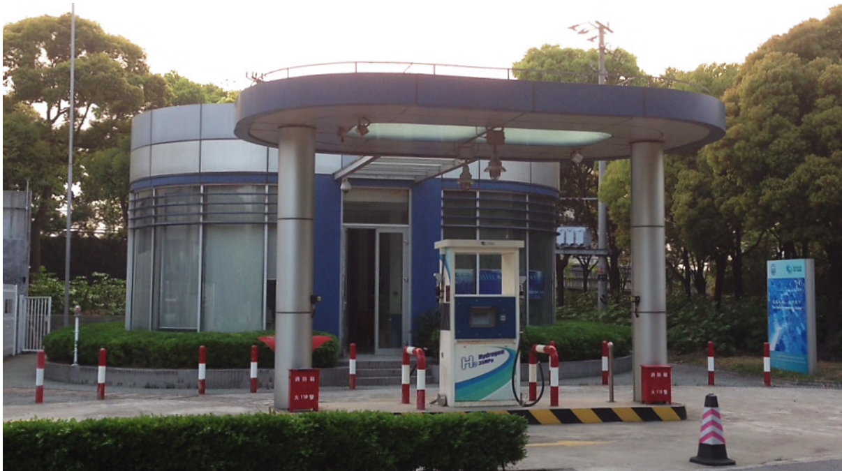
Abbildung 9: Wasserstofftankstelle in Shanghai
