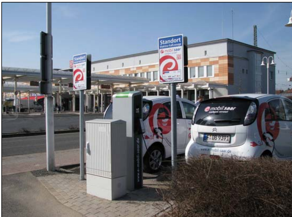
Abbildung 4-2: e-Mobil Saar Standort in Homburg am Hauptbahnhof und Busbahnhof
