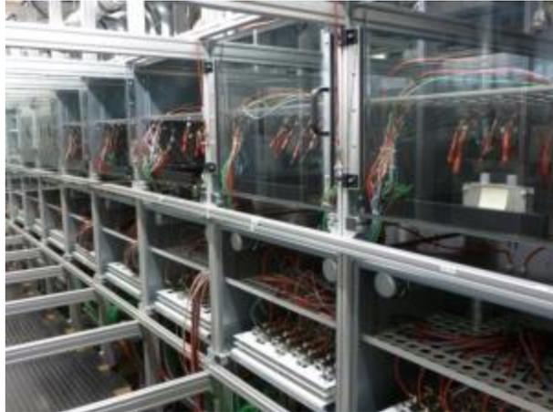
Abbildung 102: Formations- und Zykelpplätze mit Rauchgassensoren und Abluftanlage
