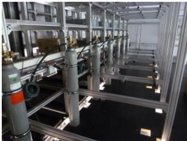
Abbildung 92: Gasversorgung der Kohlendioxidlöschanlage
