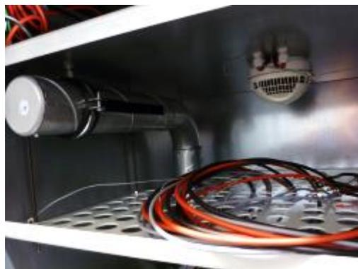
Abbildung 96: Rauchgassensor und Abluftrohr
