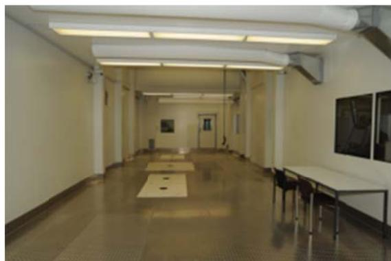
Abbildung 25: Vollständig aufgebauter Trockenraum. Am Boden erkennt man die im Boden eingelassenen Stahlplatten zur Erhöhung der Traglast von Kalanders und Kran
