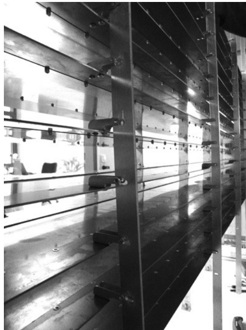
Abbildung 45: Jalousie-Biegebleche und Verbindung zu den Zugstangen
