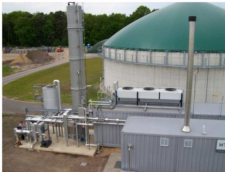
Abb.1: Foto der Biogasanlage und Aufbereitung nach dem Prinzip der drucklosen Aminwäsche.
