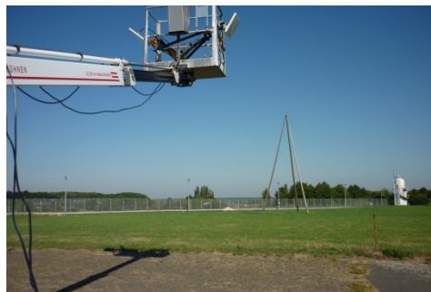
Abbildung 16: Zwei RFID-Antennen an Hebebühne befestigt (Höhe ca. 4,5 m)
