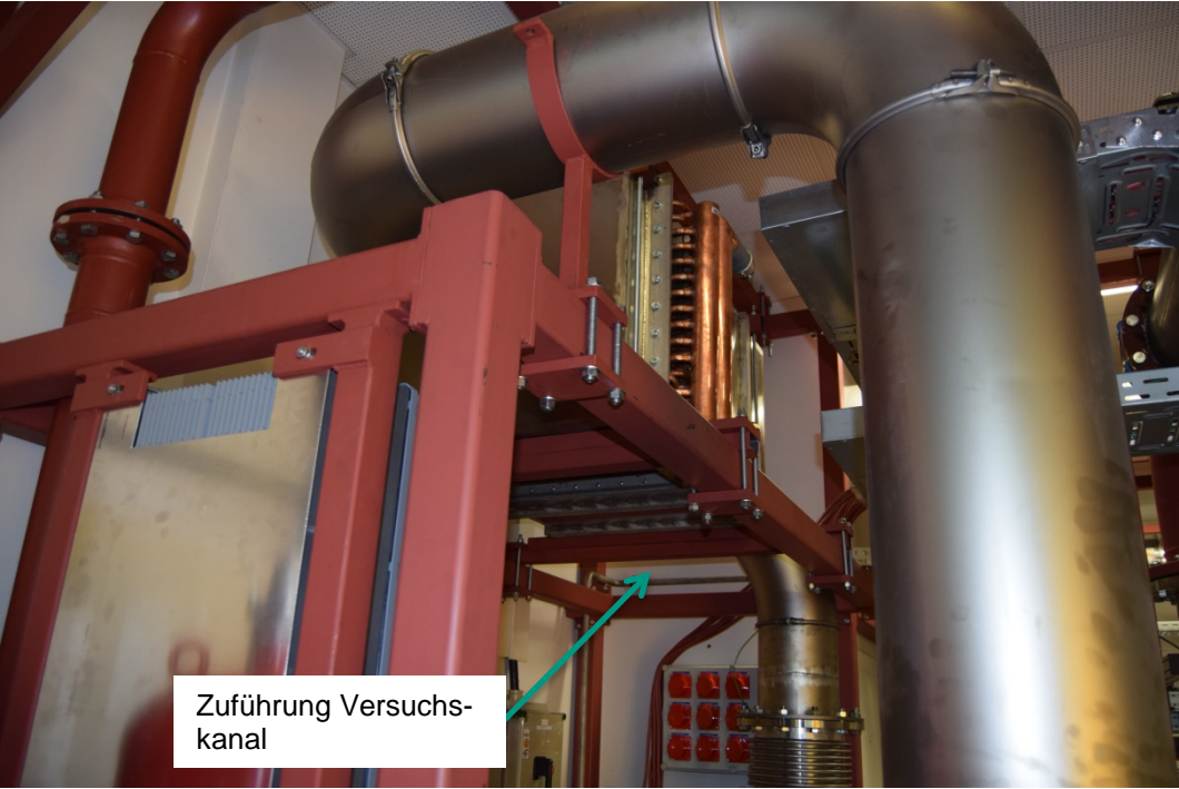
Bild 6: Verrohrung Austritt Kühler
