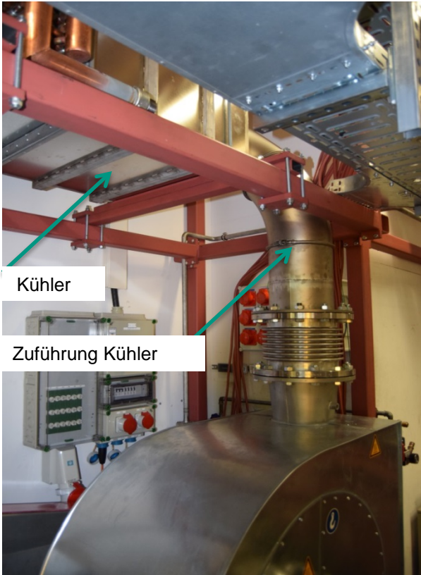
Bild 7: Verbindung Gebläse Kühler
