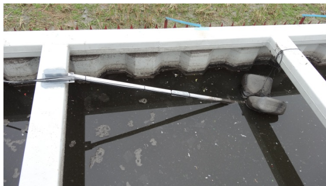
Messensoren SBR-Reaktor Aufhängung Messensoren SBR-Reaktor
