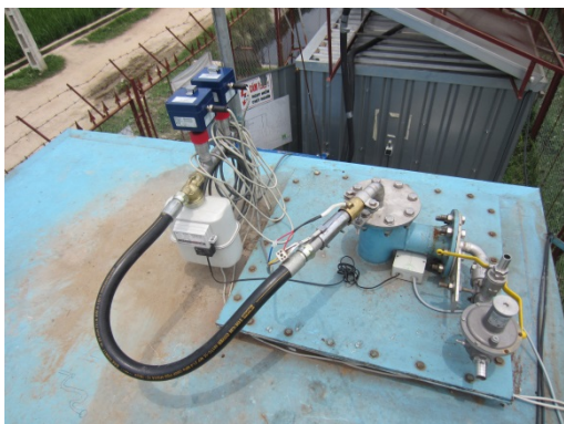
Messensoren SBR-Reaktor Aufhängung Messensoren SBR-Reaktor
