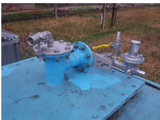
Messstelle Fermenter (Gasmessung, Gaszählung) Messeinrichtung Fermenter
