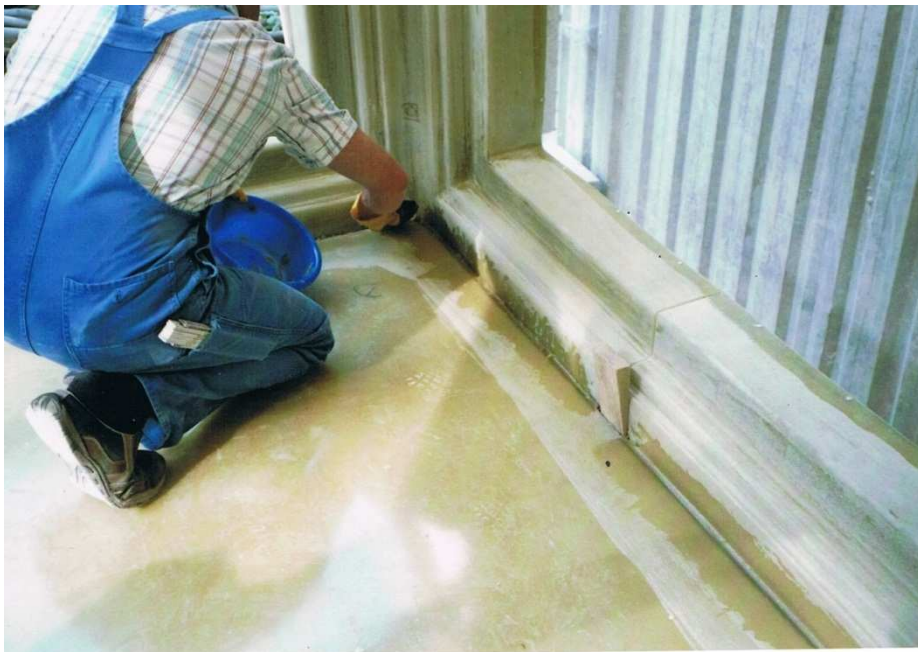
Abb. 3.18 Einbau (und verspachteln) des Bodenmoduls nach dem Einfügen (beachte Distanzkeile) in den Rahmen aus Schenkeln der Eckmodule
