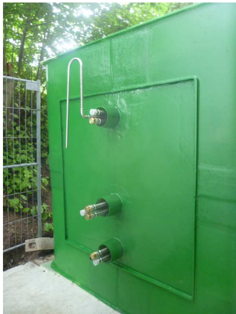
Bild II.30 Vormontage Wanddurchführungen
