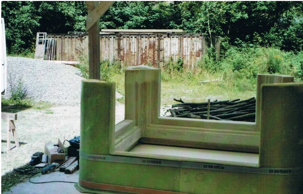
Abb. 3.15 Zusammengesteckte Dreibeinmodule als Speicherunterteil
