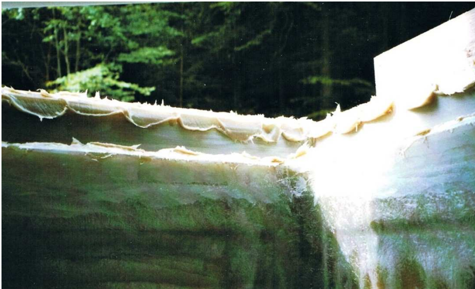
Abb. 3.20 Fugenvorbereitung zum Einbringen des Deckelmoduls
