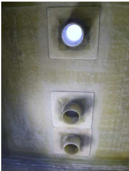
Bild II.26 Hüllrohr für Doyma-Wand- führung, laminiert
