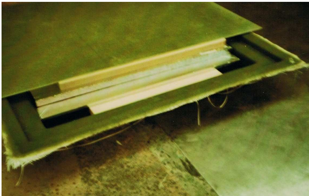
Abb. 3.8 Demonstration des Innenaufbaues bei der V III Seitenwand
