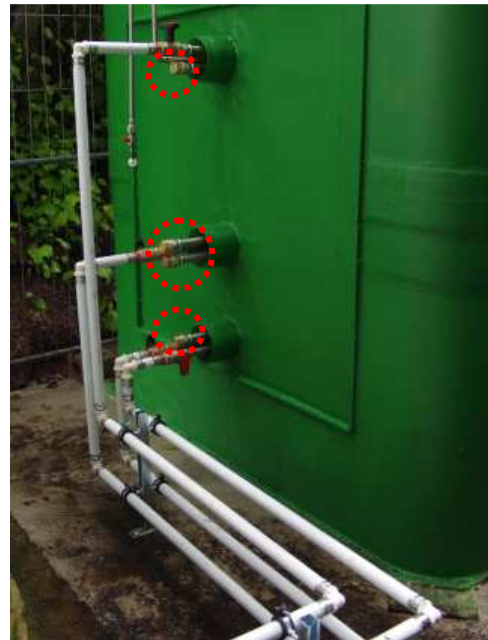
Bild II.31 Anschluss an Energiesysteme des Labors
