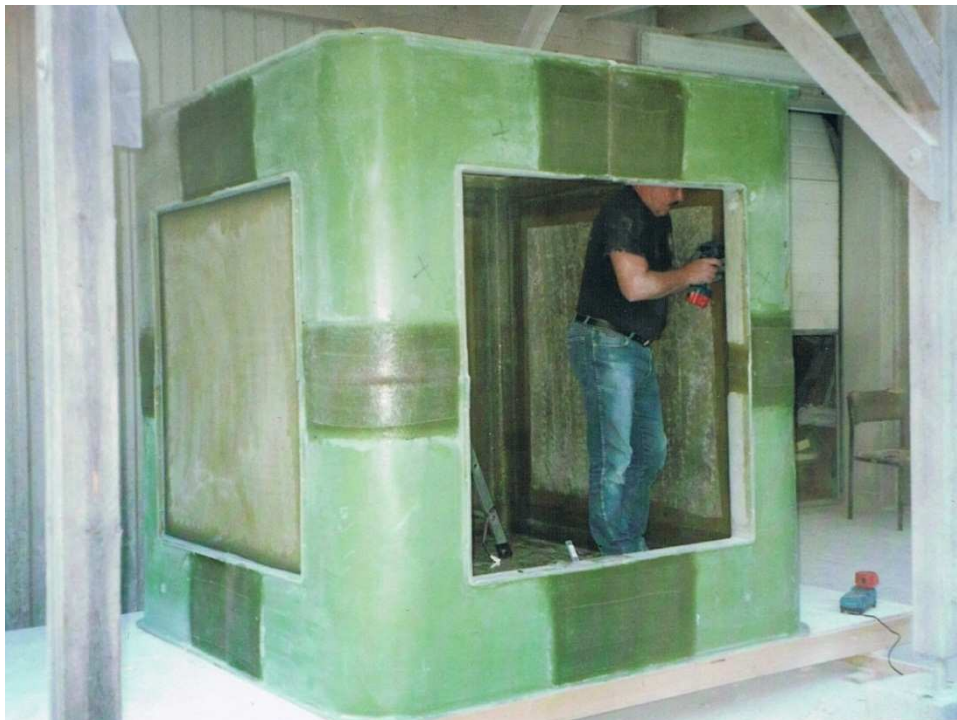
Abb. 3.16 Alle 8 zusammengesteckten und verklebten (überlamierten) Eckmodule im Stadium des Einbaues eines Seitenwandmoduls
