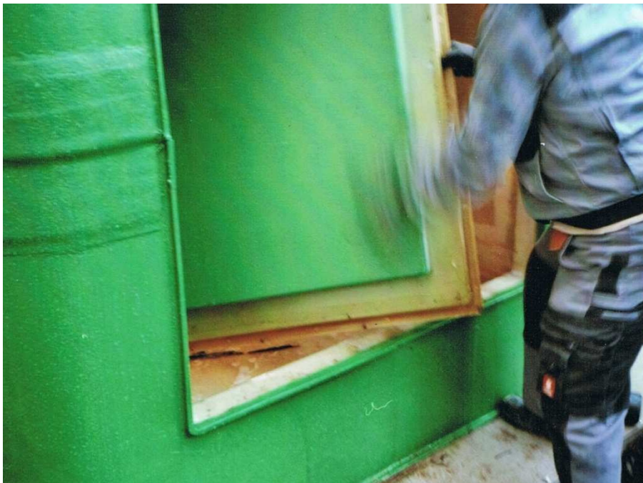
Abb. 4.6 Ausbau von Wechselmodul V I und nachfolgend Einbau von V II (14.01.2015)
