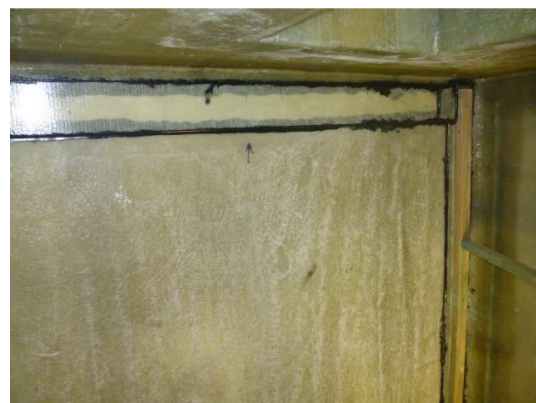
Bild II.8 Austauschbares Seitenwandmodul abgedichtet
