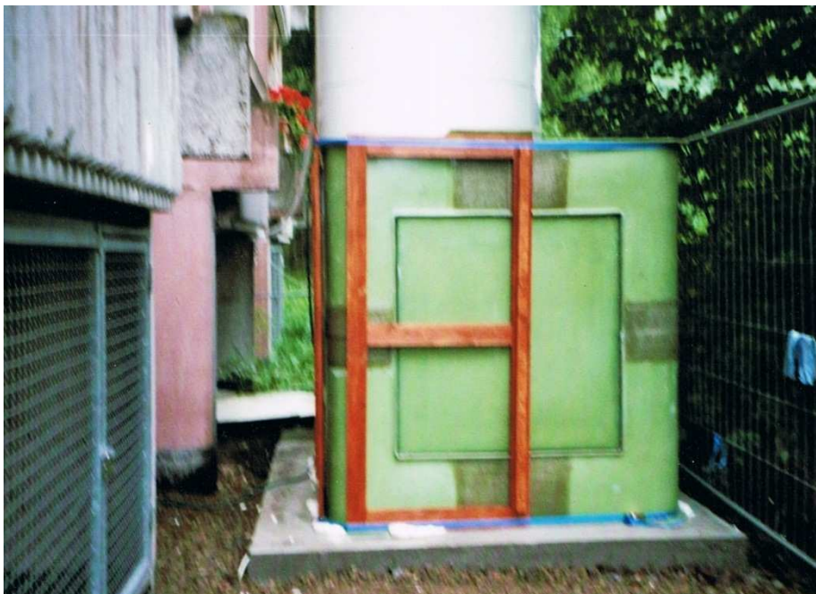
Abb. 4.3 Vermessung der Auswölbung im rechtwinkligen Koordinatensystem (im Blickfeld die auswechselbare Wand)
