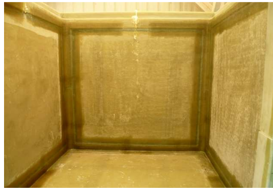
Bild II.6 Teilmontage Modulverbindungen überlaminiert
