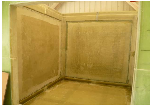
Bild II.5 Teilmontage Module verklebt
