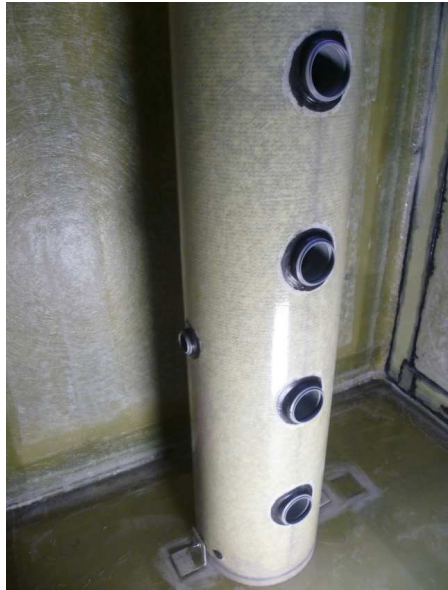
Bild II.14 Schichtlader int. gedämmt
