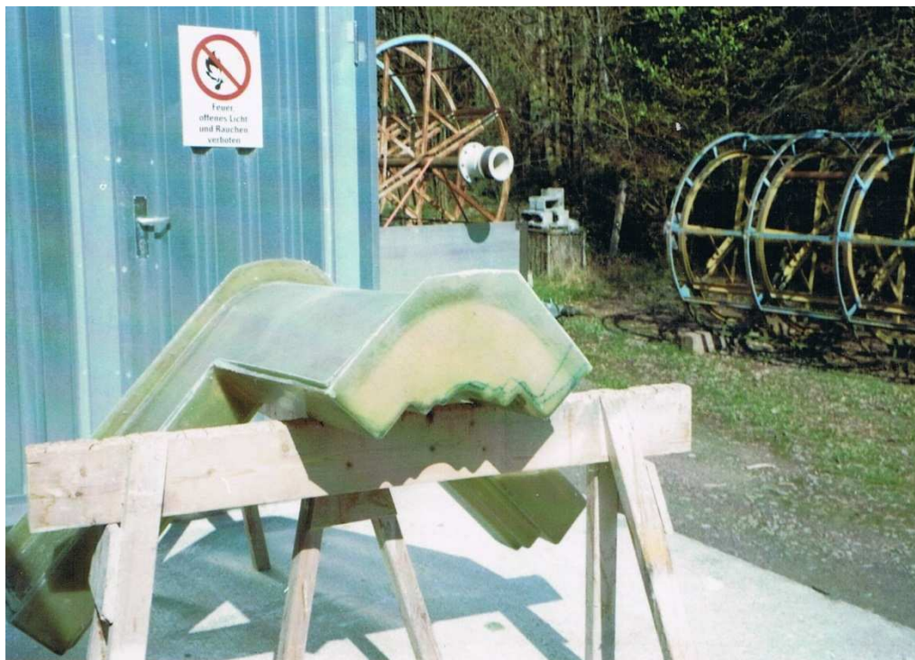
Abb. 3.6 Nach dem Verbinden der Innen- mit der Außenschale durch Überlappung und Ausschäumen mit PUR entstandene Ecke
