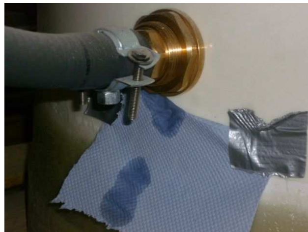
Bild II.22 Durchführung durch stark gekrümmte Wandung ( \varnothing=700 mm), undicht
