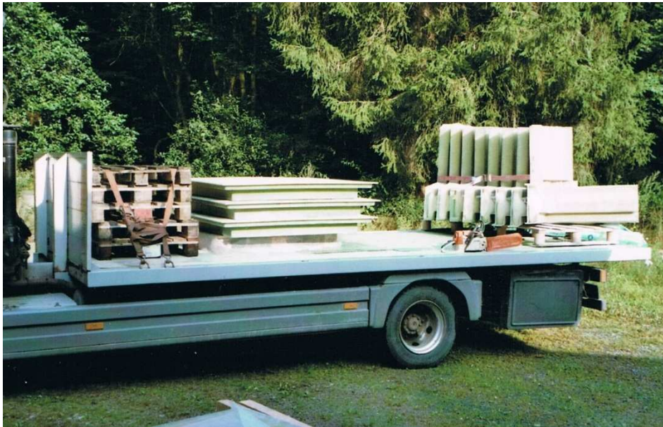
Abb. 3.13 Vorbereitung: Bereitstellung aller GFK – Einzel-Module
