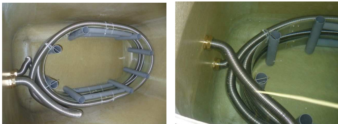
Bild II.11 Wärmetauscher auf flachem Gestell gewickelt/im Dichtheitsversuch
