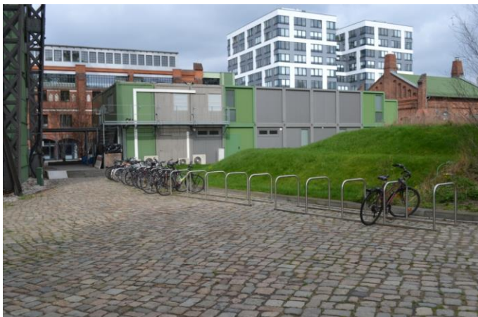
Abbildung 19: Foto von der Fahrradabstellanlage am Gasometer (Quelle: FG SPB, Foto-Aufnahmen vom 07.04.2014)
