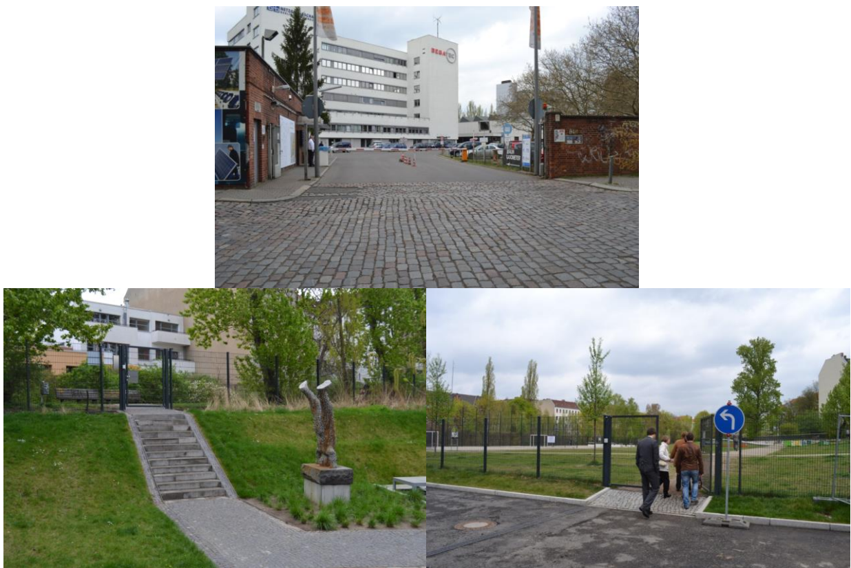
Abbildung 16: Fotos der drei Zugänge - oben: Zugang 1, links: Zugang 2, rechts: Zugang 3 (Quelle: FG SPB, Foto-Aufnahmen vom 07.04.2014)
