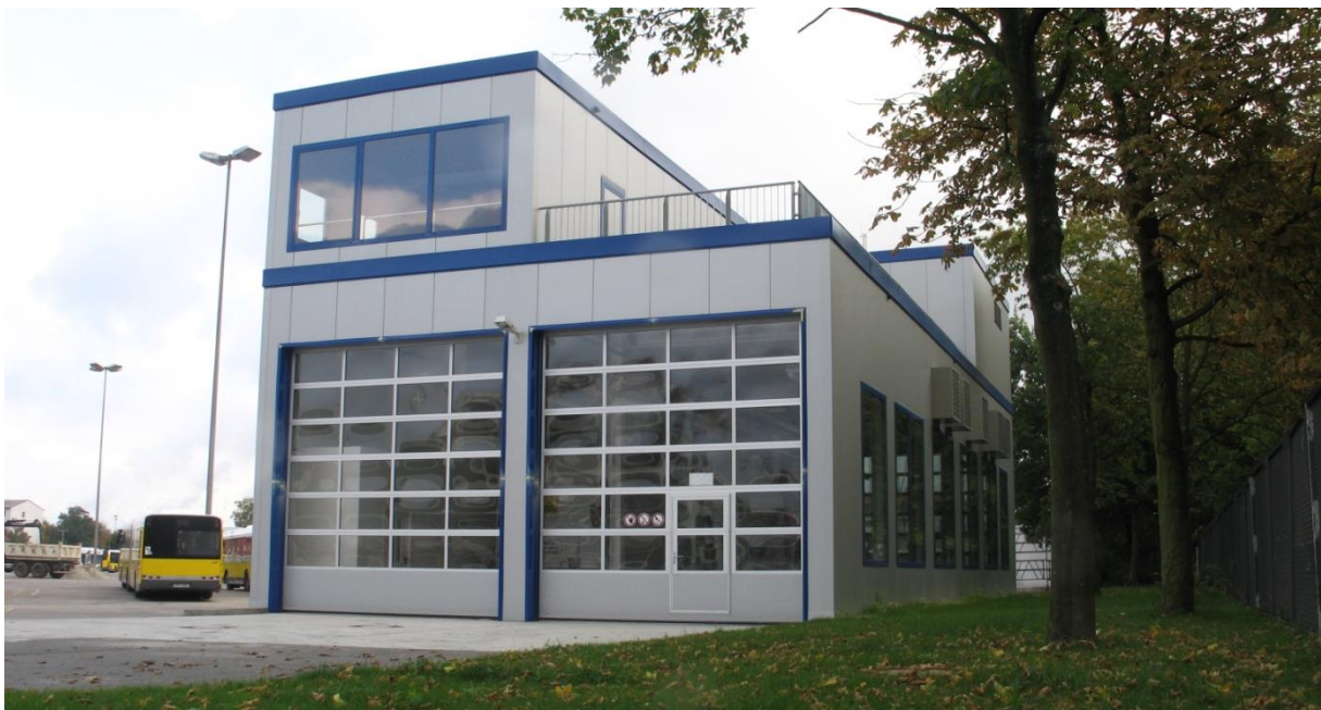
Abbildung 21: Wasserstoffbuswerkstatt an der Heerstraße
