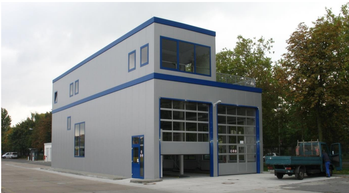
Abbildung 13: Werkstatt für die Wasserstoffbusse auf dem Gelände der BVG Heerstraße
