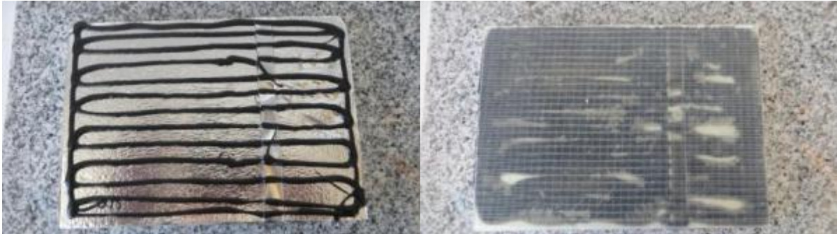
Abbildung 62: Aufgetragener Klebstoff links und Paneel mit glasfaserverstärkter Kunststoffplatte verklebt rechts
