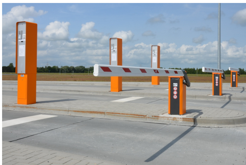
Abb. 60: Schrankensystem JadeWeserPort mit TruckerCard-Terminal
