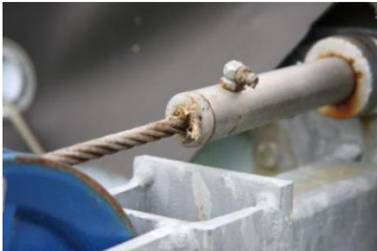
Abbildung 5: Seildurchführung eines Tauchmotorrührwerks als Emissionsquelle [2]
