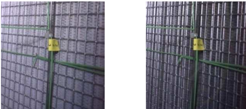
Abbildung 2.9: Außenwärmeübertrager vor und nach dem Abtauen
