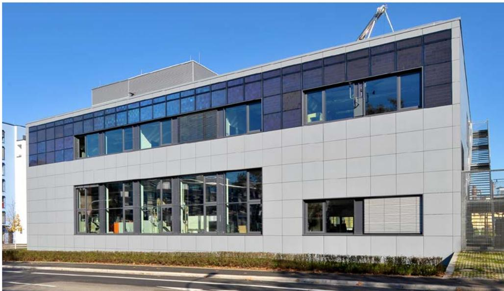
Neubau R – ein Laborgebäude des Fraunhofer-Instituts für Solare Energiesysteme ISE mit 70 Photovoltaik-Modulen aus eigener Entwicklung und Pilotproduktion ©Fraunhofer ISE
