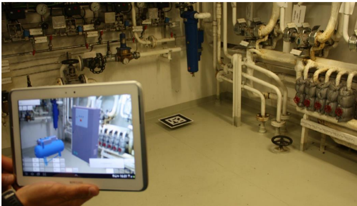
Abbildung 93: Einblendung von Komponenten des Abgasreinigungssystems
