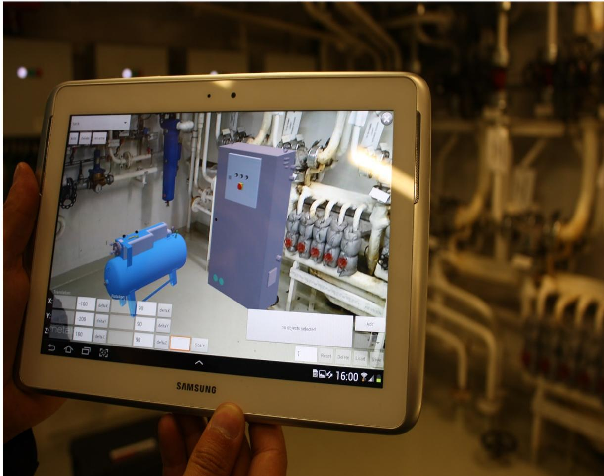
**Abbildung 10 Variantenplanung mit Augmented-Reality Methoden**
