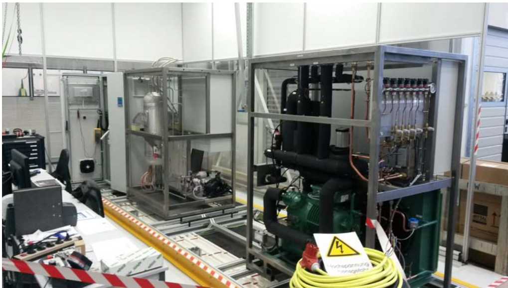
Abb. 8: Bau der CO 2 -Kühlanlage „IBelle“ für den PXD und SVD. Im Vordergrund ist der kommerzielle Freon-Kühler zu sehen, dahinter der Akkumulator für das CO 2 und danach die Kontroll-Kabine. Die CO 2 Kühleinheit ist bereits gebaut, ist aber noch nicht auf den Rahmen montiert.
