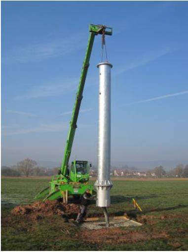
Fig. 49: Setzen des Masts
