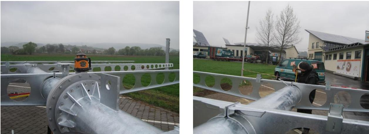
Fig. 55: Tragarmausrichtung mittels Rotationslasers
