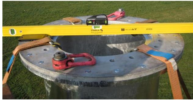
Fig. 50: Mast in Waage ausrichten
