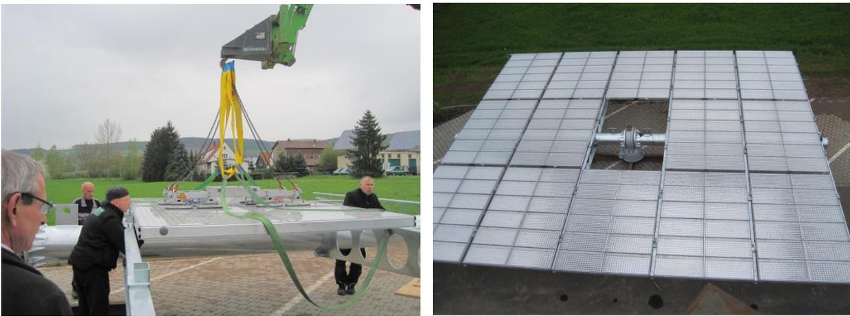
Fig. 40: Modulmontage mittels Vakuumheber
