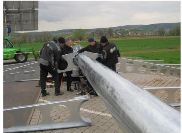
*Fig. 53: Tragarmmontage 1. Versuch*
