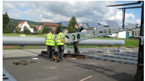
*Fig. 54: Tragarmmontage, 2. Versuch*
