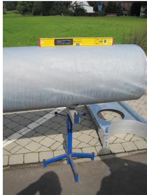
Fig. 52: Tragrohr ausrichten
