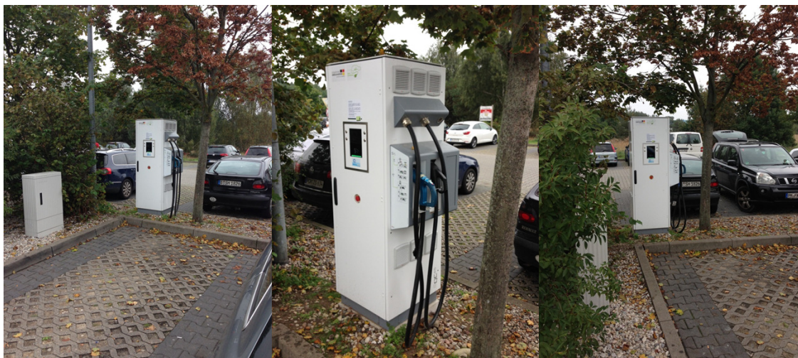
Abbildung 24: Efacec QC 45 am Standort Linthe
