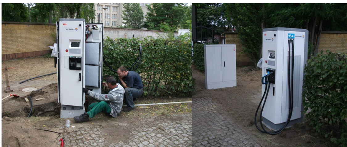
Abbildung 16: Installation der ABB Schnell-Ladestation
