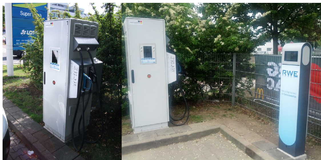
Abbildung 20: Schnell-Ladestation Alboinstraße mit abgesetztem Terminal
