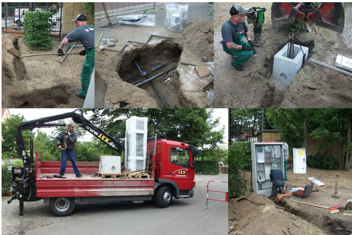
Abbildung 15: Installation der ABB Schnell-Ladestation
