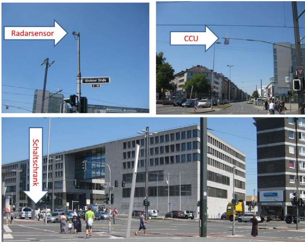
Abbildung 28: Komponenten der IRS am Oberbilker Markt in Düsseldorf
