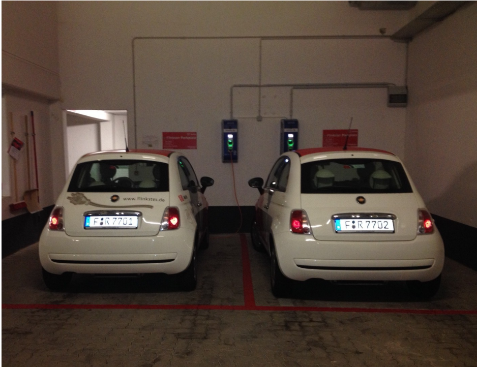
Abbildung 4: Station Hopfenstraße – e-Fiat in der Tiefgarage
