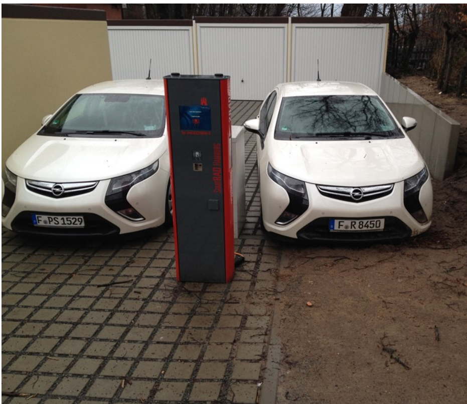
Abbildung 7: Station Rosentreppe – starke Verschmutzung aufgrund fehlender Hangbegrenzung
