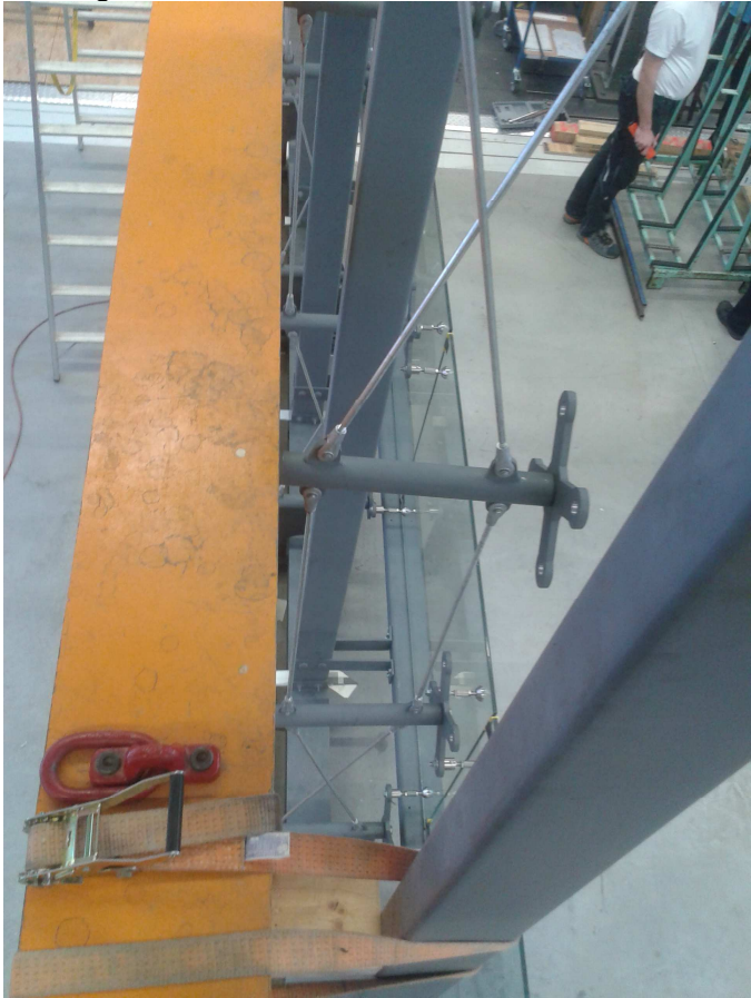
Montage der Glasscheiben von unten nach oben
