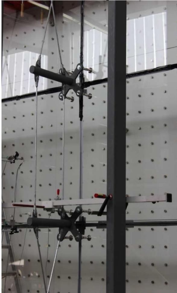
Weiche Fassade mit Messgeräten
