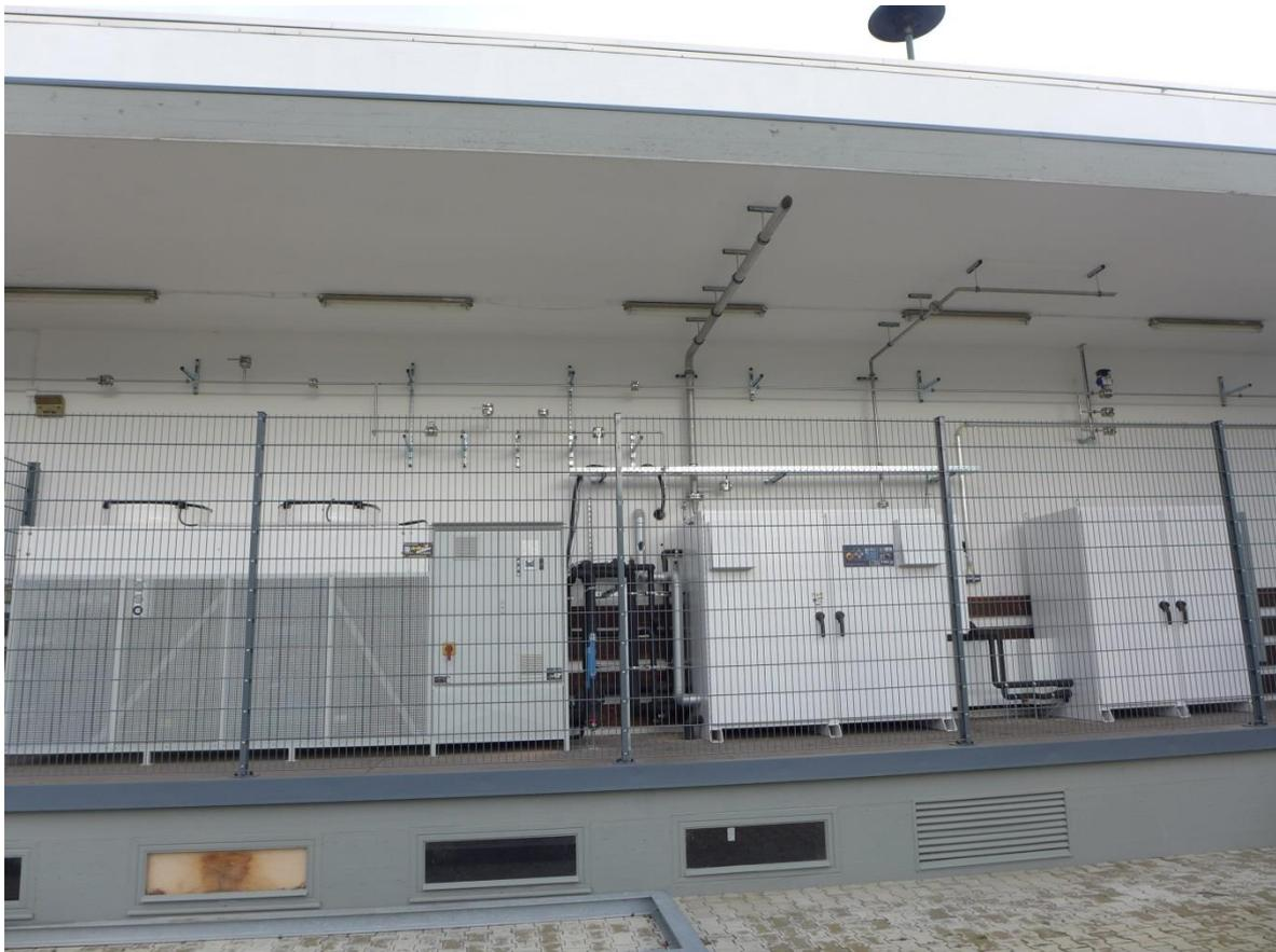
Abbildung 1: Gesamtanlage Wasserstoffversorgung
