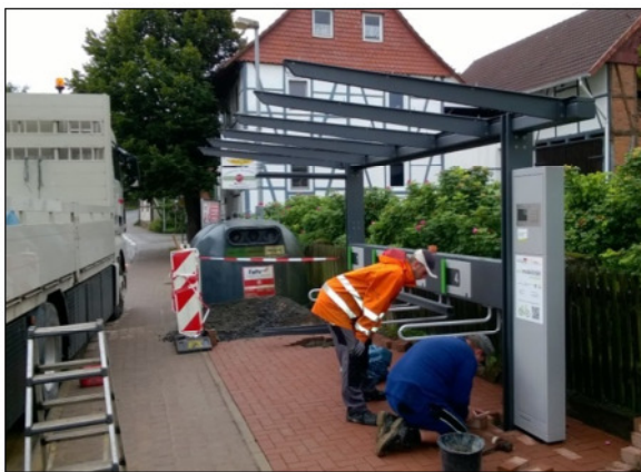
Abbildung 43 - Montage einer offenen Pedelec-Verleihstation in Reiffenhausen Quelle: Landkreis Göttingen, 2015
