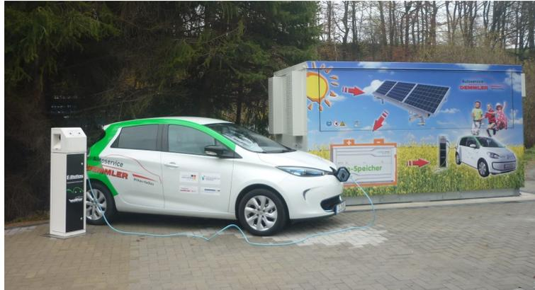
Abbildung 19 Ladesäule mit Energiespeichersystem
