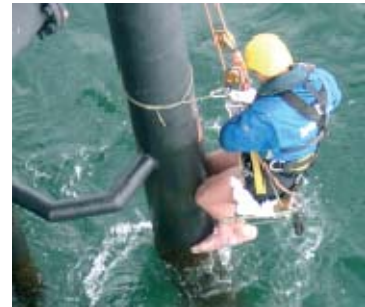
Abb. 4: Wartungsarbeiten an einem Offshore- Bauwerk. ii
