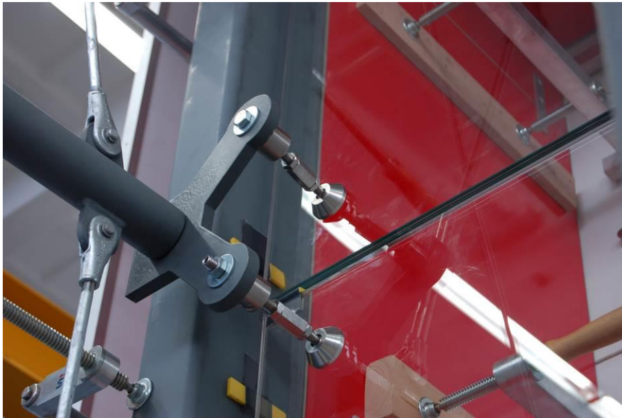
Bild 24 Punkthalter- anschlüsse Seilnetzfassaden- konstruktion, Randknoten
