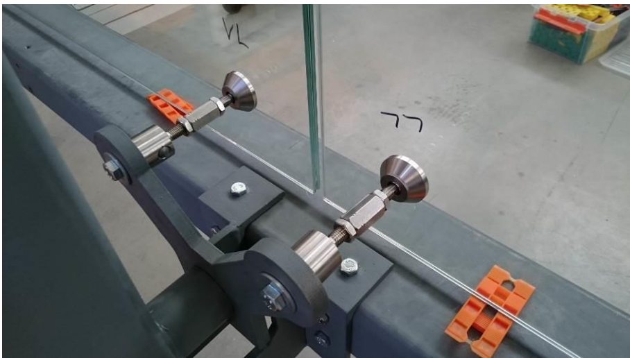
Bild 22 Punkthalteranschlüsse starres Fassadenmuster (Pfosten-Riegel-Fassade) - Randknoten
