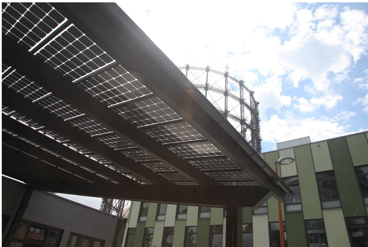
Abbildung 15: Solarcarport nach Fertigstellung auf dem EUREF Campus
