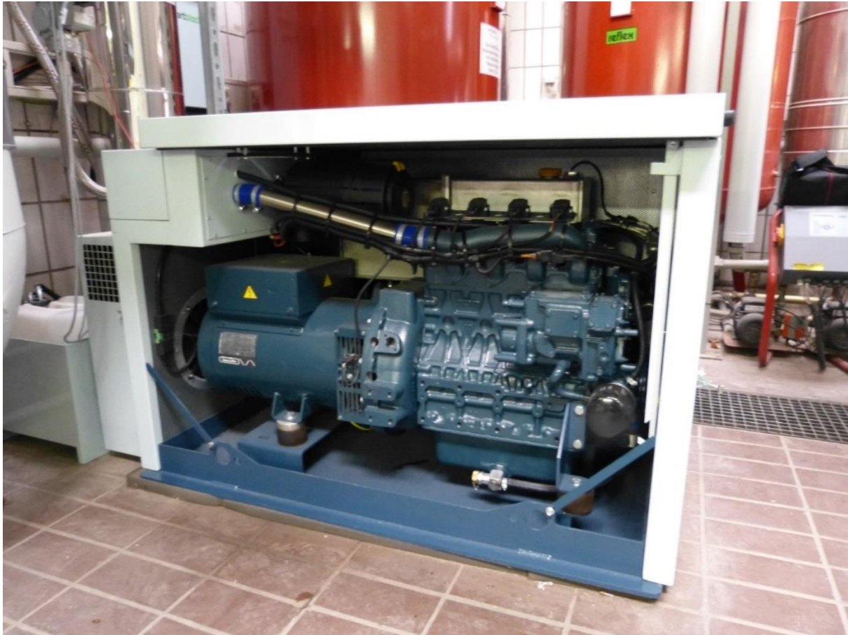
Abbildung 14: Blockheizkraftwerk
