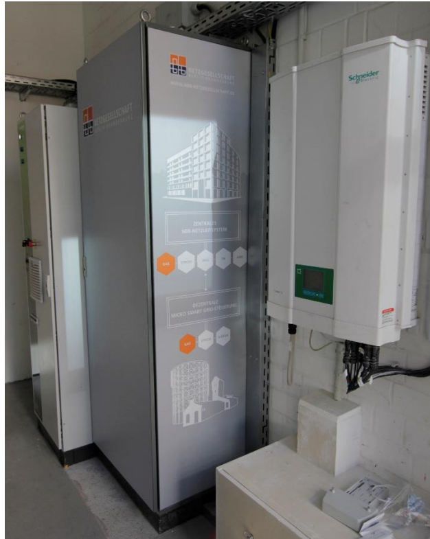
Abbildung 19: Fernwirkkopf NBB (mitte)
