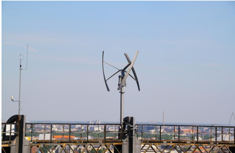
Abbildung 18: Kleinwindenergieanlagen KD VK-58 auf Gasometer in Berlin-Schöneberg [Quelle: RLI]
