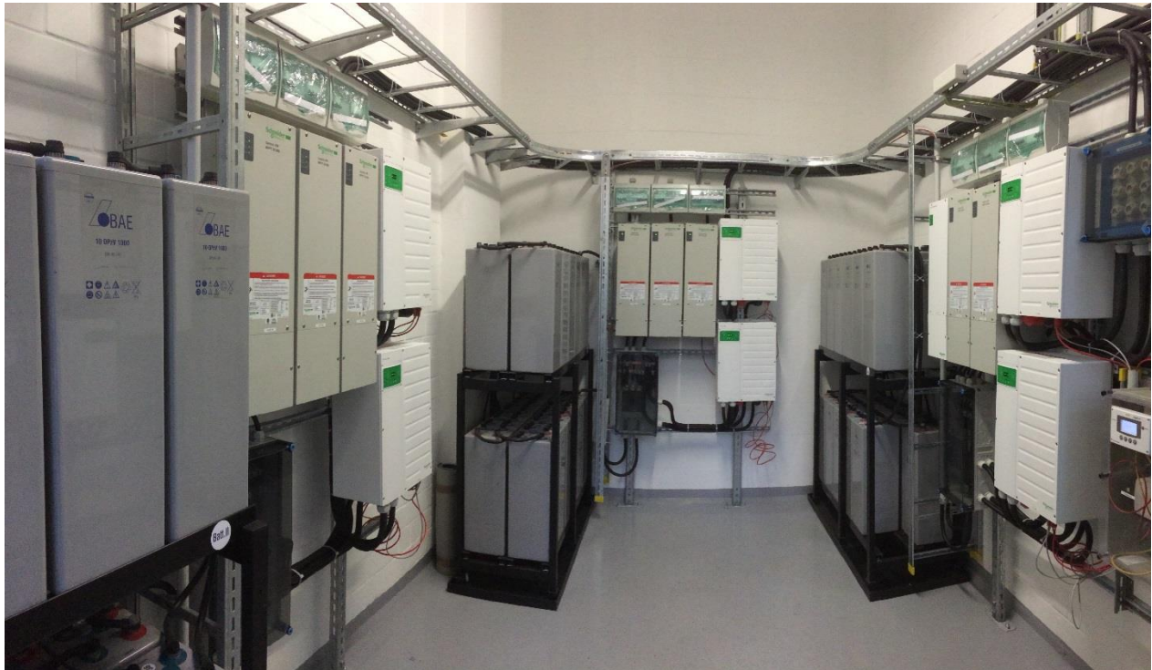
Abbildung 16: Bleibatteriecenter
