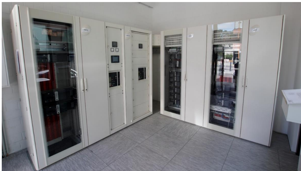
Abbildung 12: Niederspannungshauptverteilung
