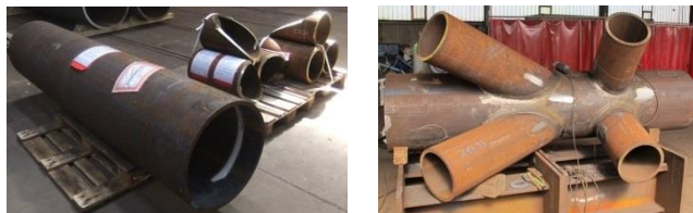
Abb. 56 a) zugeschnittene Rohre; b) Demonstrator während der Fertigung bei WeserWind
