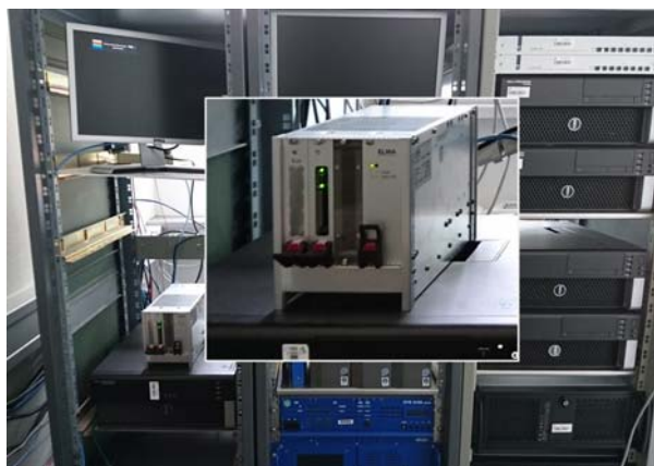
Abbildung 16: Für die Simulatorstudie in das GECO integrierte Zielhardware Remote Graphics and Video Controller von Diehl Aerospace
