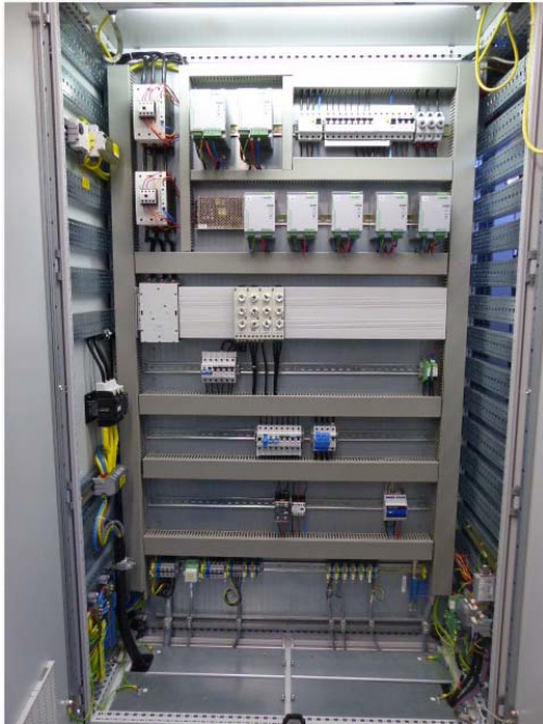
Abbildung 26 Hochvolt- und Niederspannungsschaltschrank (rechts) nach Umbau
