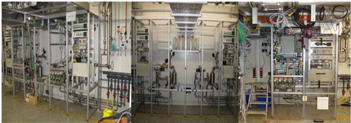
Abbildung 25 Umbauphasen der Medienversorgung (Original, Rückbau, Neuaufbau)
