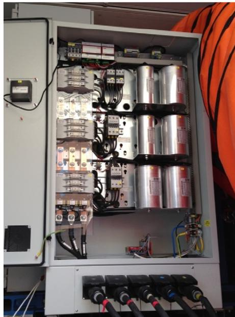
**Abbildung 6-28:** Schaltschrank mit den Komponenten der Blindleistungskompensation
