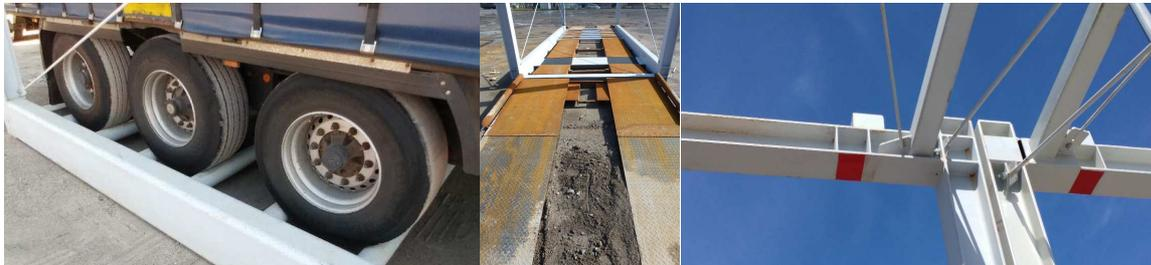
Abbildung 19: v.r.n.l. Radmulden, Rampe, Verbindung Quer- und Längsträger
