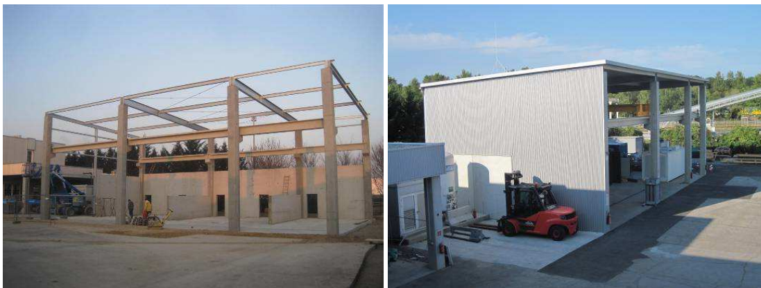
Abb.3: Teststand in Bau (links) und nach Fertigstellung (rechts)
