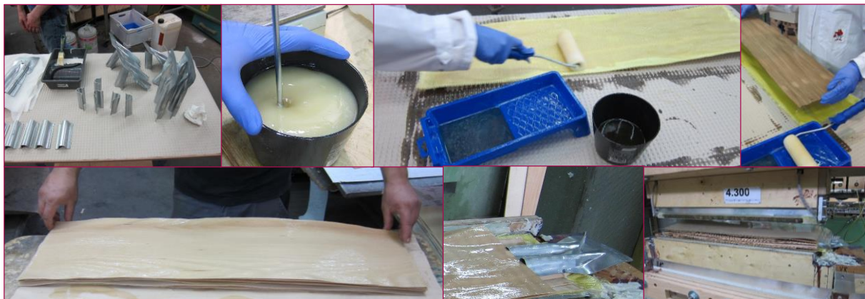
Abbildung 53: Eindrücke der Herstellung eines Demonstratorbauteils.
