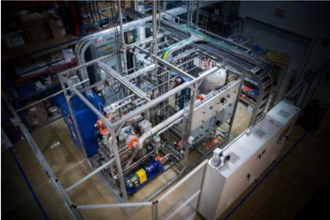
Abbildung 89: Teststand zur Vermessung der Kurz-Stacks
