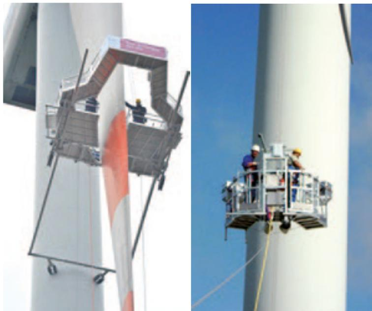
**Abbildung 5: Seilarbeitsbühne für Rotorblatt und Turm (Käufer GmbH)**
