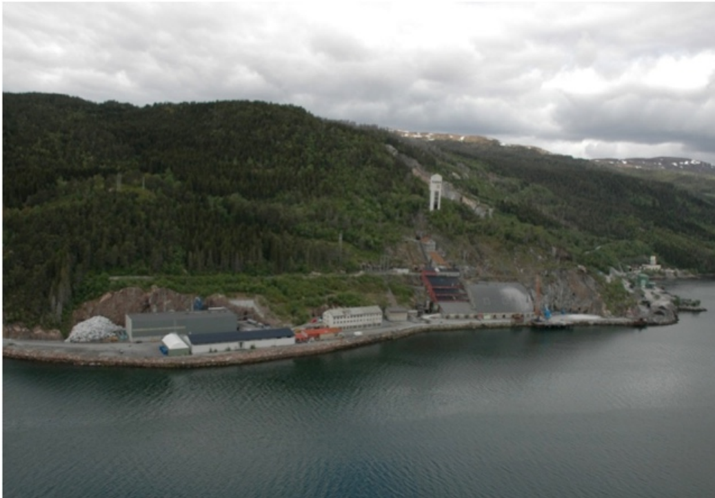
Abb.29: Salzschlacken Aufbereitungsanlage Aleris Aluminium Norway
