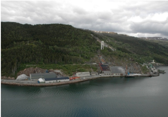
Abb.20: Salzschlacken Aufbereitungsanlage Aleris Aluminium Norway
