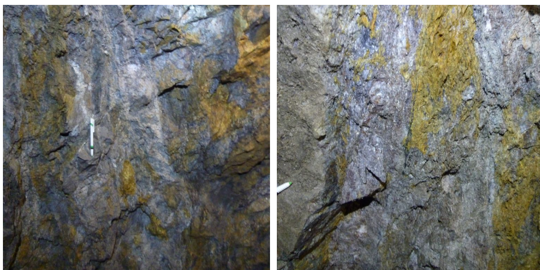
(a) Foto der Störungszone 200b
