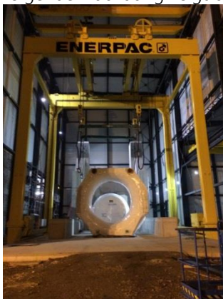
Abb. 08: Anlieferung Stator
