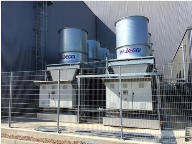
Abb. 42: Hybrid Kühltürme DyNaLab
