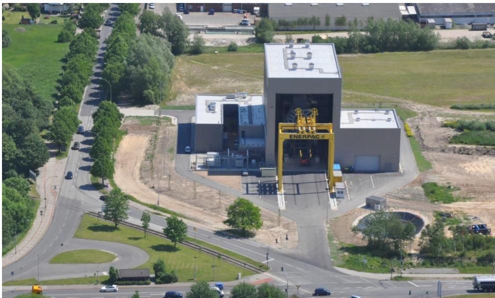
Abb. 01: DyNaLab mit Hubgerüst
