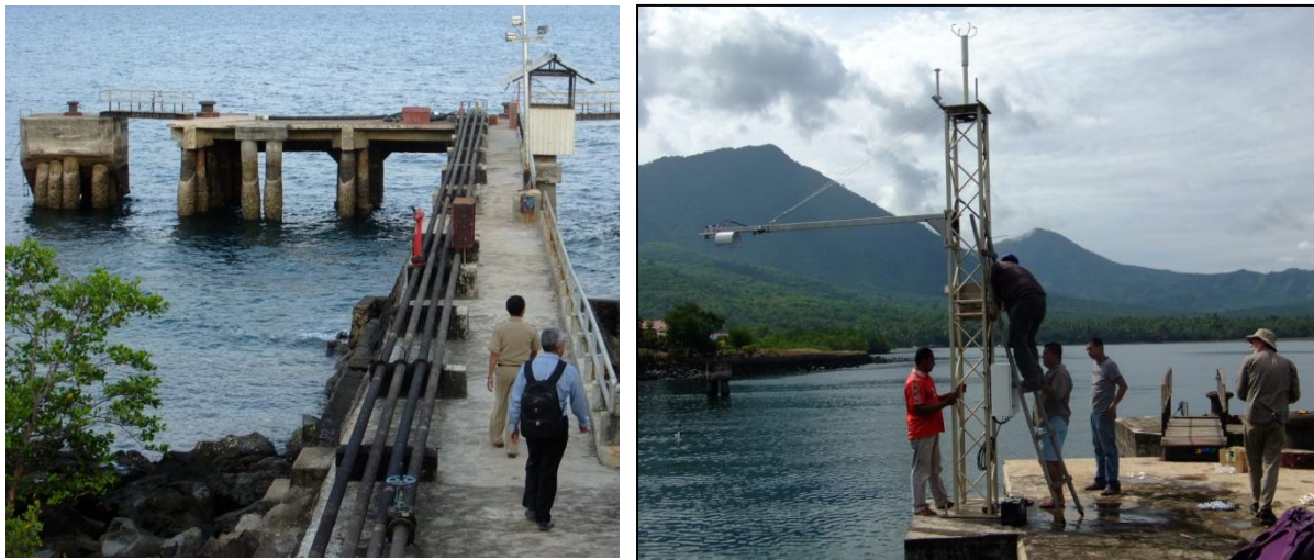
Abb. 35: Pier der Ölfirma PERTAMINA, Zusammenbau und Aufrichten des Pegelsystems.
