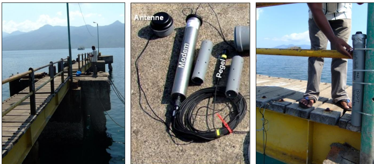
Abb. 36: Ferry Port Larantuka, Installation von Tauchpegel (Cera Diver) und Modem.
