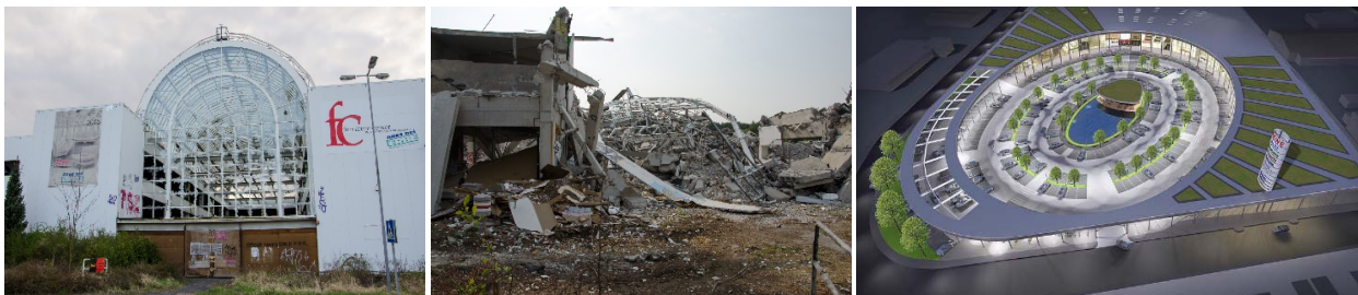
Abbildung 58: Ehemaliges Möbel Erbes Gebäude in Hanau Steinheim vor und nach dem Abbruch (Fotos: Benjamin Schnitzer), sowie die neue Planung eines Einkaufszentrums auf diesem Gelände ( www.rondo-steinheim.com/projektbeschreibung ).
