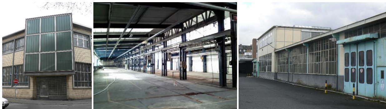
Abbildung 59: Leerstand der ehemaligen MAN-Roland Montagehalle in Offenbach vor der Umnutzung (Fotos: Christoph Diepes).
