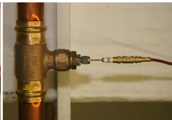
**Bild 12** Messstelle zur Erfassung der Gastemperatur
