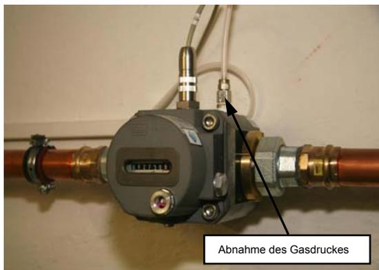
**Bild 11** Drehkolbengaszähler zur Erfassung des Gasverbrauches
