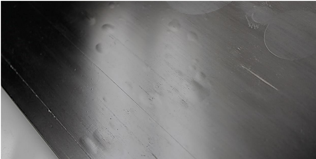
Abbildung 43 Blasen im ausgehärteten Bauteil
