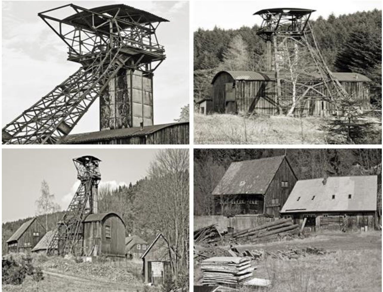
Abbildung 4: Fotos des Medingschachtes der Grube Bergwerkswohlfahrt [18]
