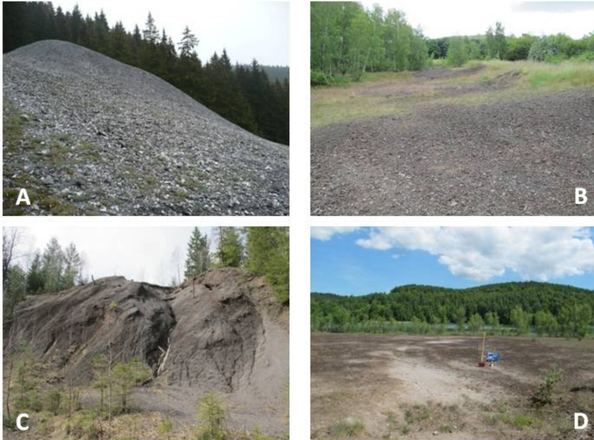
Abb. 1.2: Beispiele verschiedener Haldentypen. A: Grobbergehalde bei Oberschulenberg. B: Schlackenhalde am Kahnstein bei Langelsheim. C: Pochsandhalde bei Bad Grund. D: Flotationsrückstände im Absetzbecken II bei Bad Grund.
