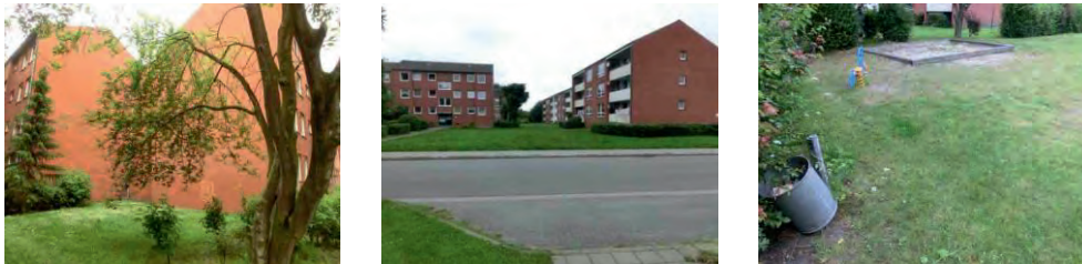
Fotos: Durch fensterlose Giebelseiten oder nur durch Nebenräume mit Fenstern fehlt die soziale Kontrolle des (halb)öffentlichen Raums, fehlende Nutzungsvielfalt im Außenraum (Fotos: LKA)
