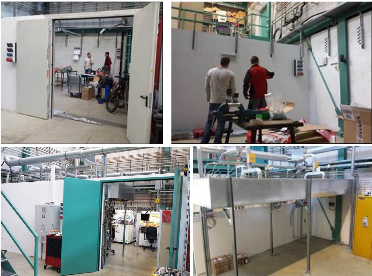
Abbildung 4: neuer Testraum ohne (oben) und mit (unten) Teststandsinfrastruktur
